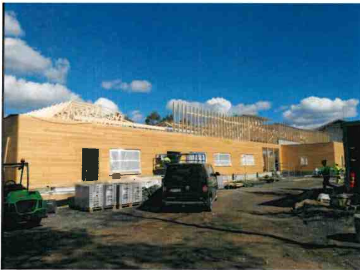
Kuva uuden koulun rakennustyömaalta 13.5.2020
