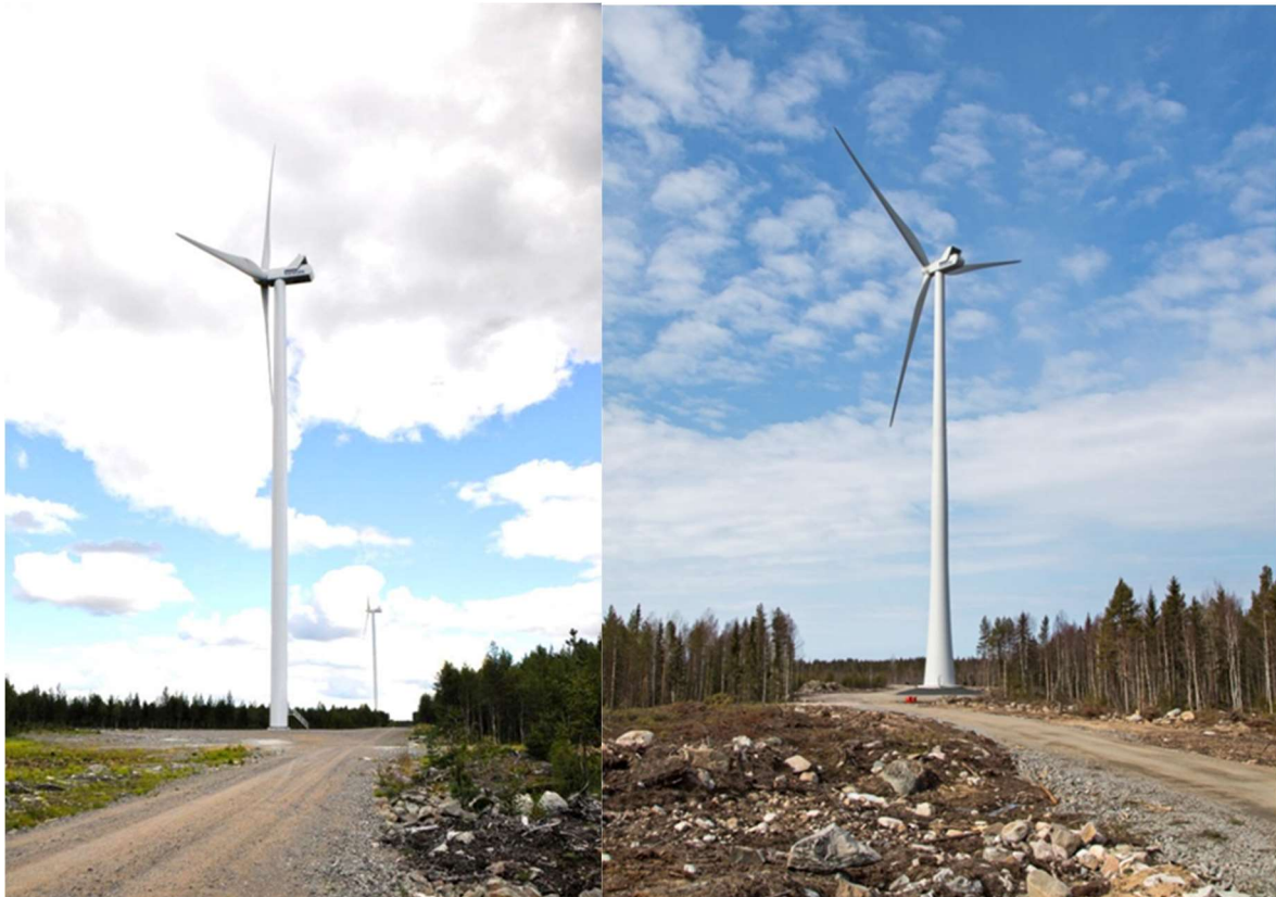
Kuva 85. Kuvapari. Vasemmalla on esimerkki teräslieriötornista ja oikealla hybriditornista (Kuvat: FCG).
