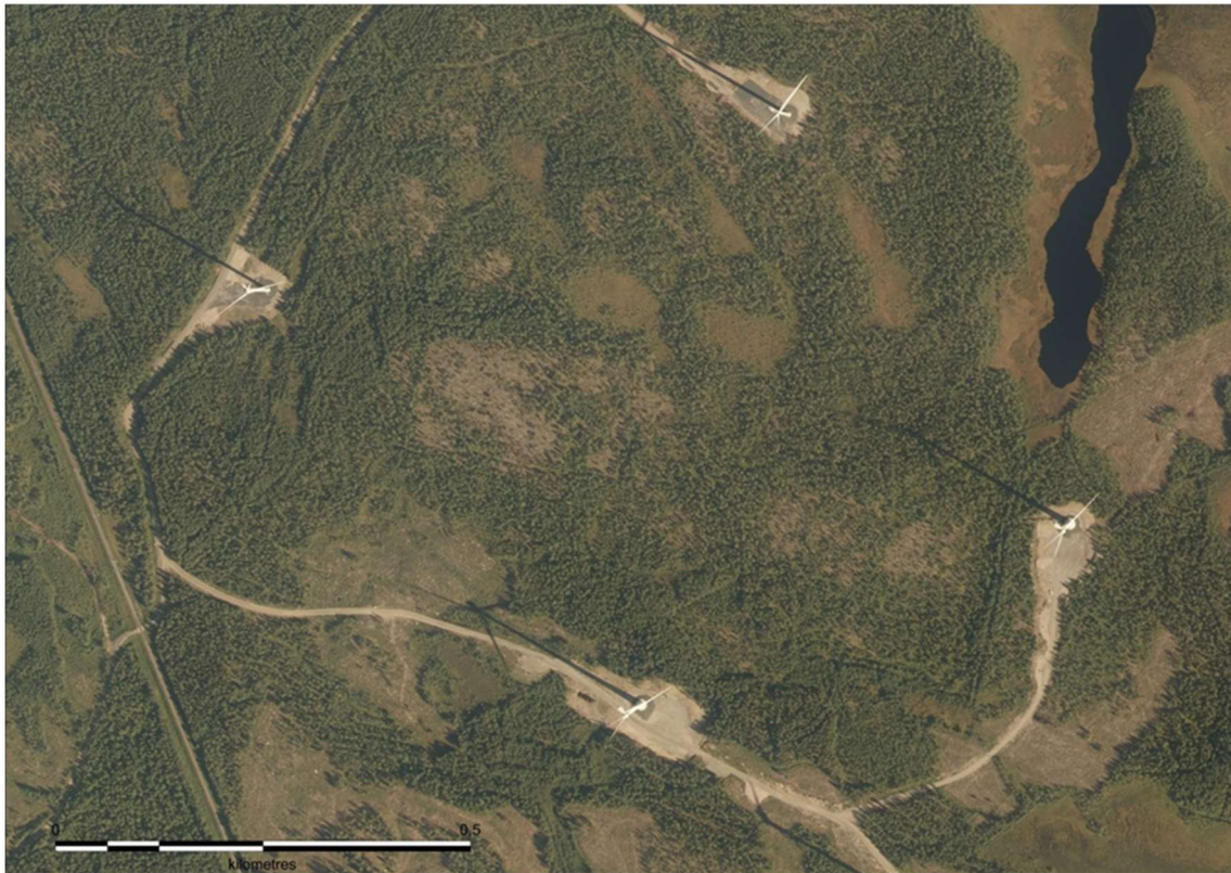
Kuva 84. Esimerkkikuva toiminnassa olevasta tuulivoimapuistosta. Tuulivoimaloita varten on rakennettu huoltotiet ja nostokentät. Tuulivoimaloiden ympäristössä ja välialueilla aikaisempi maankäyttö on säilynyt ennallaan.
