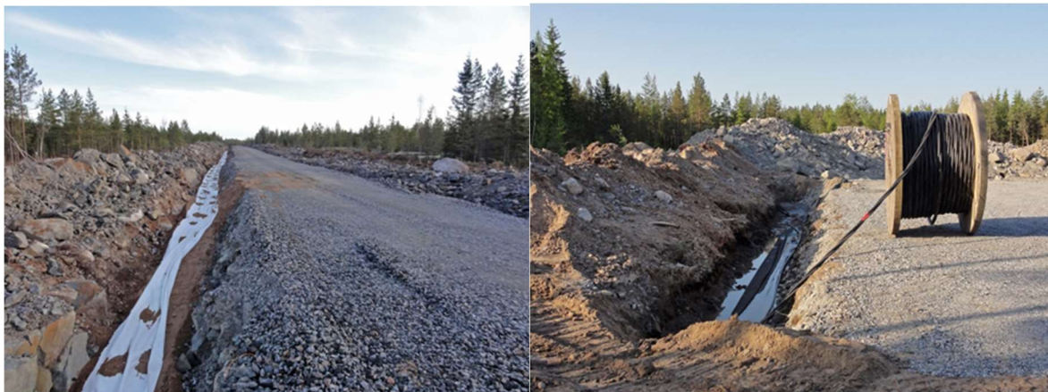
Kuva 93. Kuvapari. Maakaapelit upotetaan huoltoteiden yhteyteen (Kuvat: FCG).
