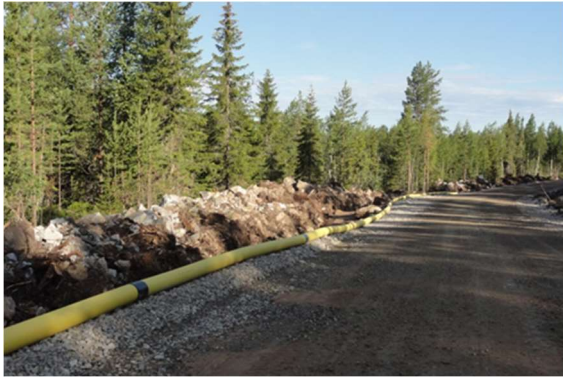
Kuva 91. Kuvapari. Vasemmalla: Esimerkki tuulivoimapuiston rakennus- ja huoltotiestä. Maakaapeli sijoitetaan ojakaivantoon tien reuna-alueelle. Oikealla: Tuulivoimalan osia kuljetetaan erikoiskuljetuksina. (Kuvat: FCG).
