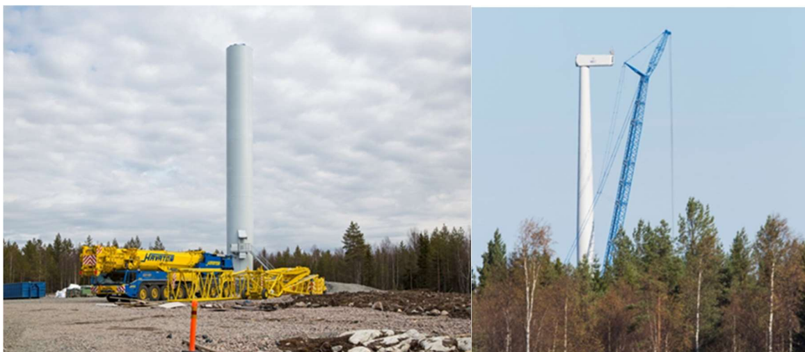
Kuva 95. Kuvapari. Tuulivoimalan kokoamista (Kuvat: FCG).
