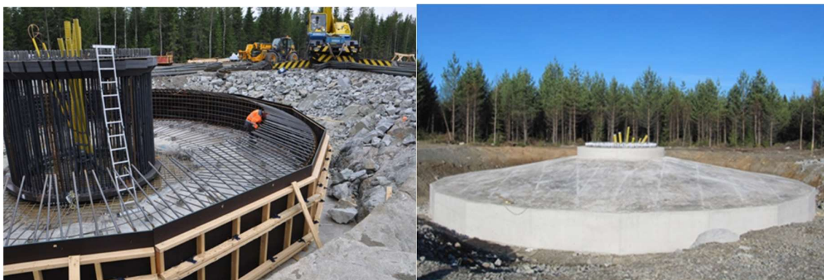
Kuva 94. Kuvapari. Tuulivoimalan perustusten rakentamista (Kuvat: FCG).
